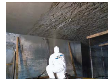
Renforcement de structures (parasismique)
