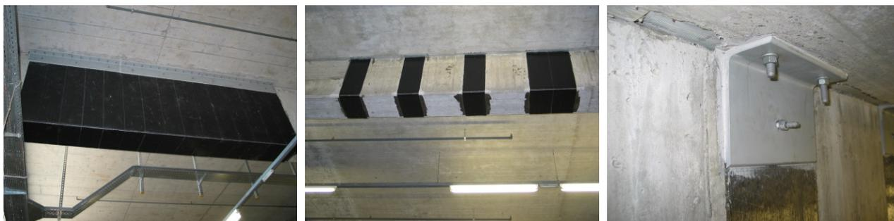
Images 42 / 43 / 44: Renforcement d'une poutre en béton armé avec des *S&P C-Sheet 640*, sur toute la surface ou ponctuellement (selon un modèle de treillis), avec ancrage dans la zone comprimée.
