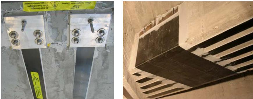
Images 18 / 19: Lamelles ancrées aux extrémités, sous dalle et sous sommier
