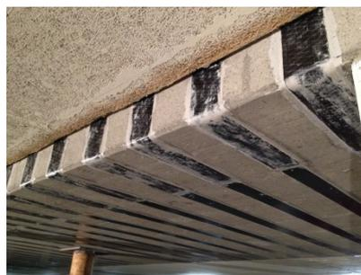
Image 46: Application en tant qu'ancrage d'extrémité
