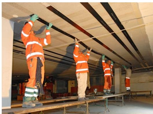
Image 8: Montage d'une S&P CFK-Lamelle
