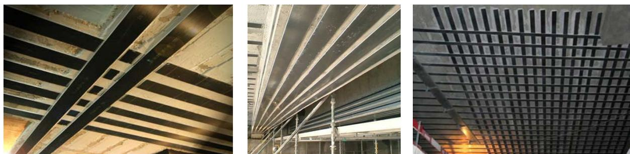
Image 10 / 11 / 12: *S&P CFK-Lamelles* collées en surface
