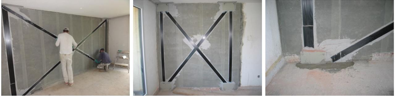
*Images 38 / 39 / 40: Renforcement sismique de maçonnerie à l'aide de S&P CFK-Lamelles ancrées dans la dalle en béton.*
