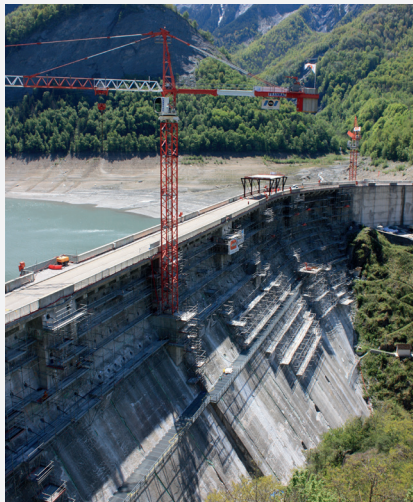
▲ Parement aval du barrage
