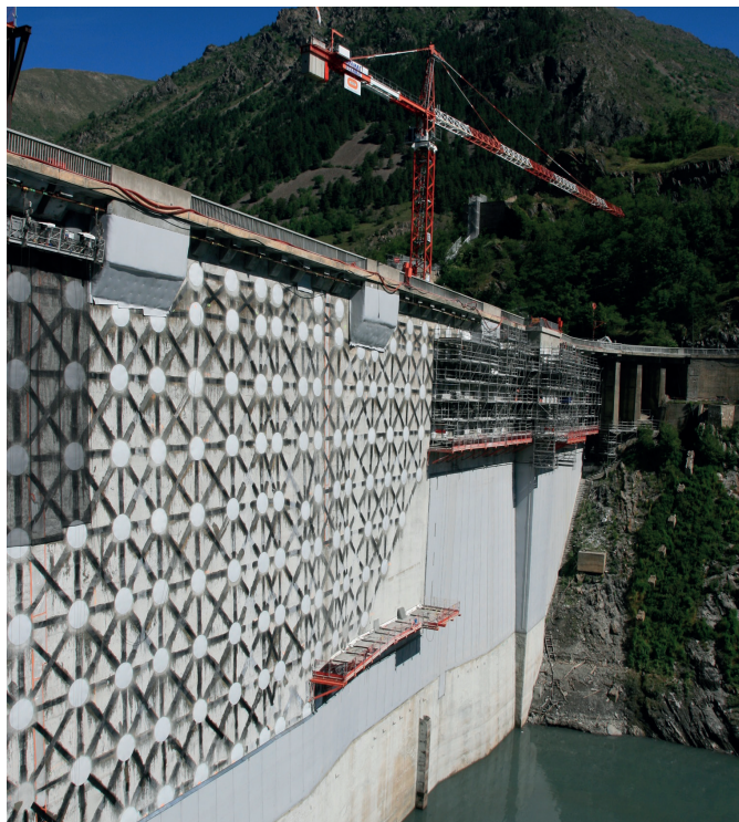
▲ Vue du maillage en S&P C-Sheet 240 sur le parement amont du barrage
