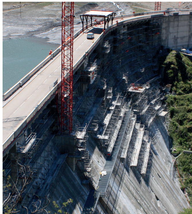
▲ Vue de l'échafaudage sur le parement aval du barrage ▲
