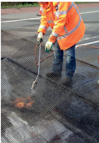
← Handmatig branden van de asfaltwapening
