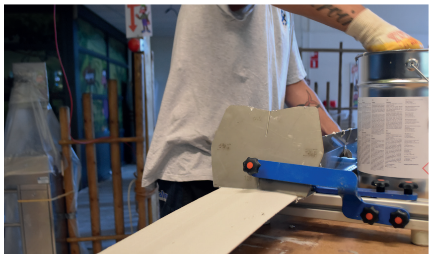
Lijm aanbrengen met behulp van S&P lijm-aanbreng unit
