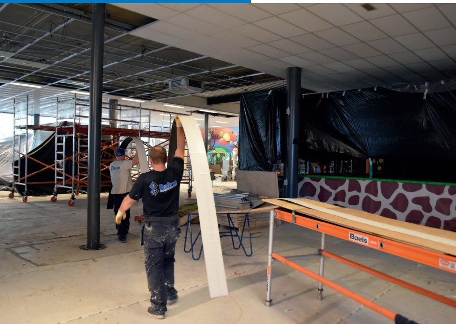
Lamellen van grote lengte monteren
