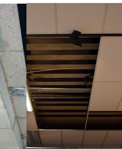
Montage tussen systeemplafond
