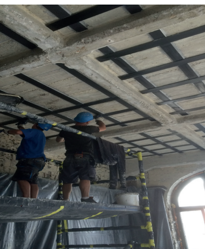
Aanbrengen koolstof lamellen
