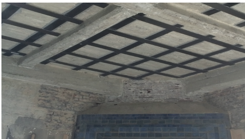
Externe lijmwapening aan de onderzijde constructie
