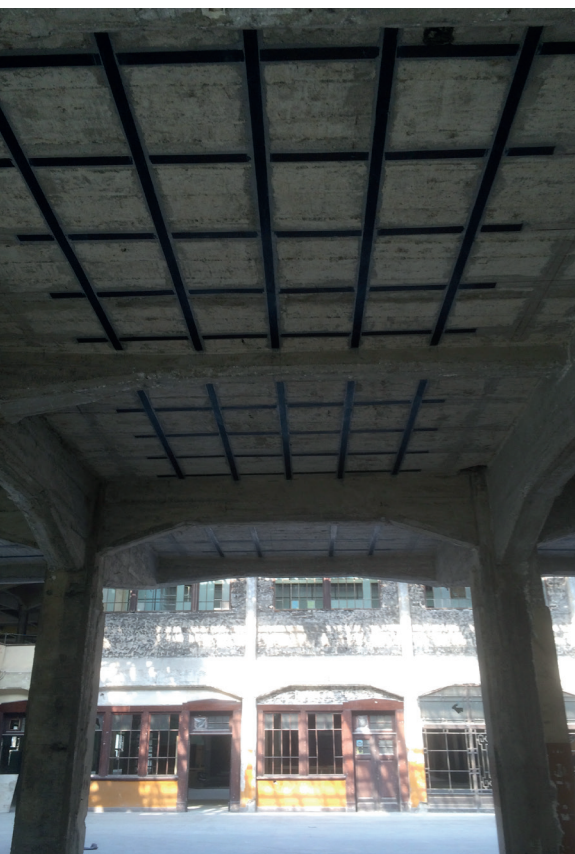
Aangebrachte lamellen met eindankers
