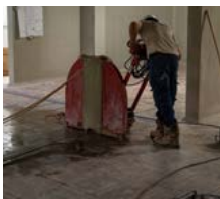
▲ Ziège de la zone à renforcer
