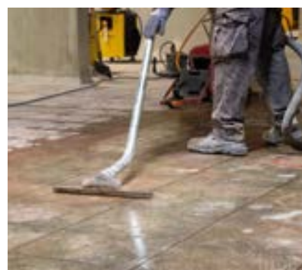
▲ Nettoyage de la zone de travail
