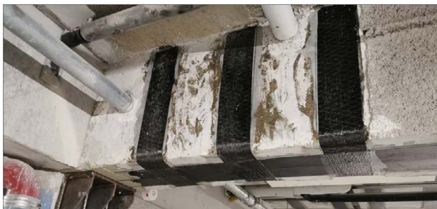
▲ S&P C-Sheet (Poutre renforcée à l'effort tranchant)
